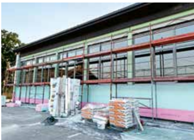
Dämmung und Neugestaltung der Turnsaal-Außenfassade
