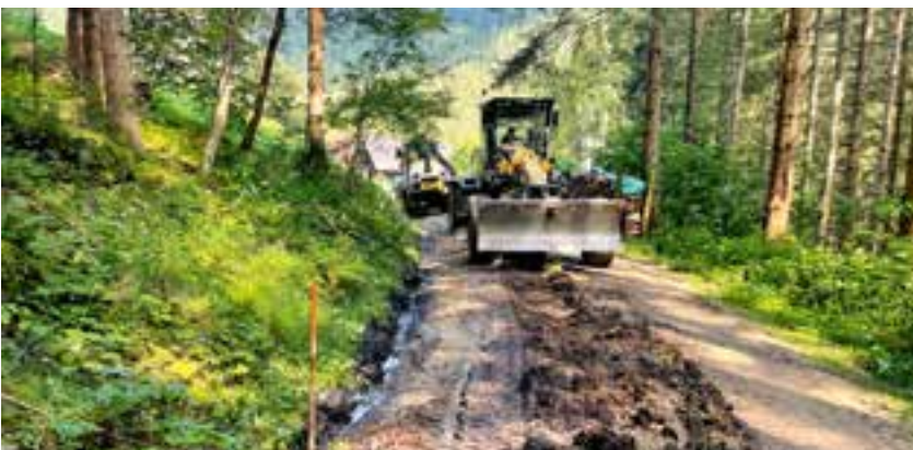
Sanierung der Hofzufahrten und Erneuerung der Durchlässe zur Ableitung des Oberflächenwassers
